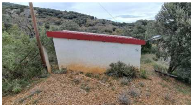
Caseta de bombeo
