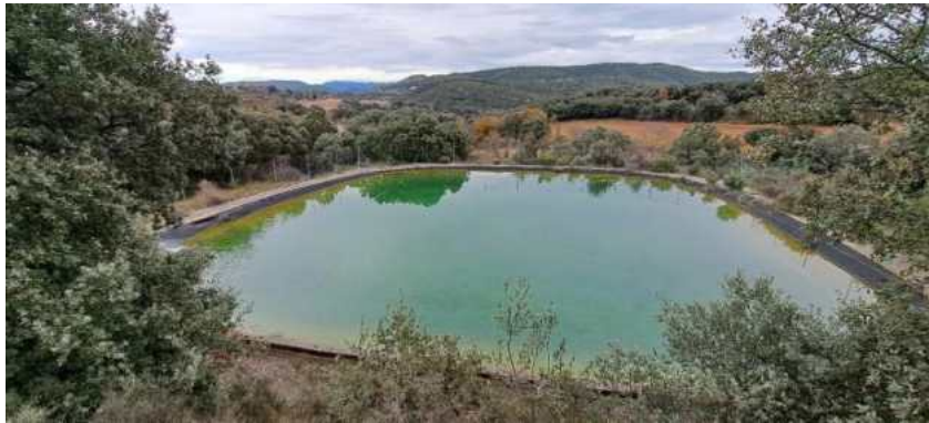
Balsa junto al bombeo sin uso
