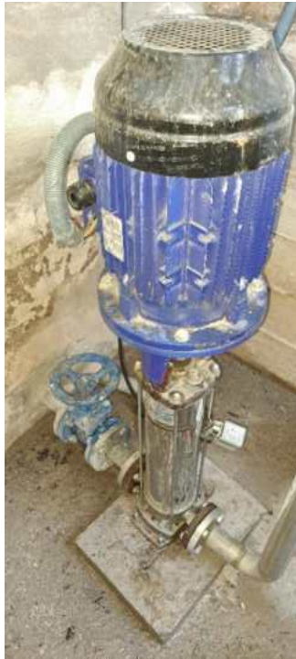
Pequeño depósito de carga de la bomba y bomba
